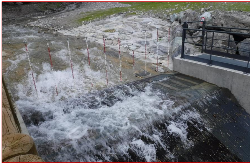
La prise d'eau de la centrale de Bozel
