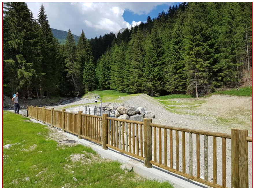
La prise d'eau vue de côté
