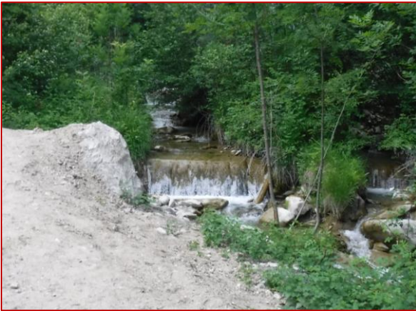
Le torrent du Bonrieu juste en amont du bâtiment de production
