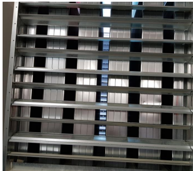
Le système de ventilation avec son piège à son
