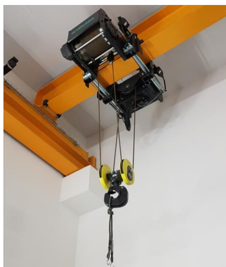
Le pont roulant
