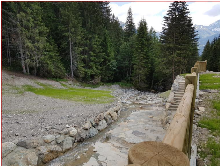
La prise d'eau vue d'en haut
